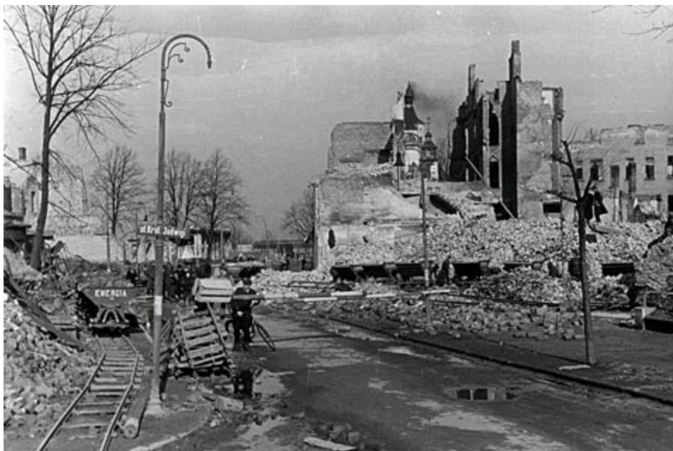
Ruiny hotelu Werminghoff, w tle wejście na molo, 1945 rok. Gruz trafil potem do Warszawy na odbudowę stolicy a część poszła na zasypianie bagna przy ul. Haffnera.
