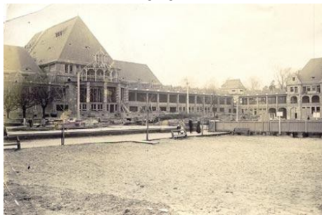
Budowa III Domu Zdrojowego, zdjęcie z 1910 r. (GK, foto. John Faltin)
