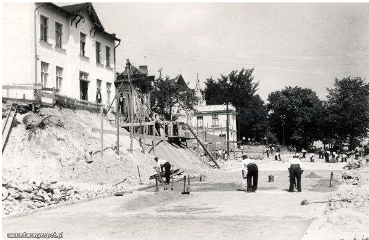
Roboty przy poszerzaniu dawnej ul. Wejherowskiej. Z lewej strony widoczny budynek pod numerem 19 i 21 (888, 890), zdjęcie z ok. 1930 r. (KC, Foto Kirschner, 1930 r.)
