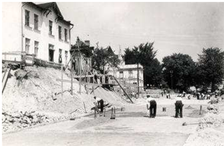
Roboty przy poszerzaniu dawnej ul. Wejherowskiej. Z lewej strony widoczny budynek pod numerem 19 i 21 (888, 890), zdjęcie z ok. 1930 r. (KC, Foto Kirschner)
