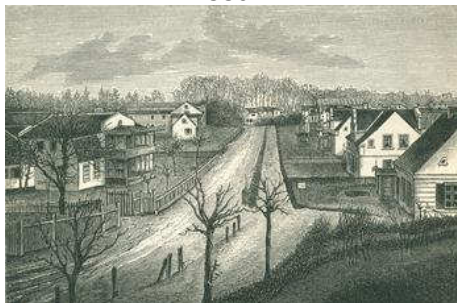
Dawna ul. Morska, widok z Morskiego wzgórza w kierunku Zatoki Gdańskiej, drzeworyt z ok. 1880 r. (KC)
