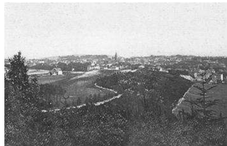
Droga prowadząca wzgórzami po północnej stronie Doliny Owczej, zdjęcie z ok. 1909 r. (KC)
