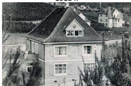
Willa przy dawnej Bullowale 24, obecnie ul. Mickiewicza 24. Zdjęcie z ok. 1915 r. (KC)
