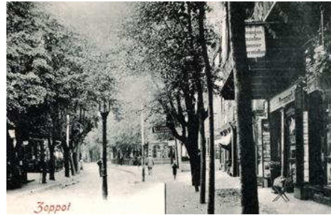
Dolny odcinek ul. Morskiej, na wysokości Willi Bellevue, należącej do Alberta Kubasiaka. Widoczny sztyld mieszczący się na parterze drogerii i pasmanterii Hansa Brunnerta, sprzedającej między innymi sopockie widokówki. Zdjęcie z ok. 1900 r. (KC, Reinicke & Rubin)
