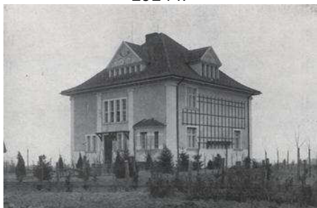
Willa Momber przy Cesarskim Wzgórzu 6, zdjęcie z 1914 r. (BUW, Ostd. Bau-Zeitung 1914)
