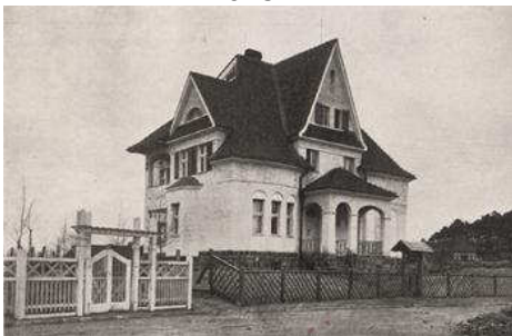
Willa Drager przy Cesarskim Wzgórzu 4, zdjęcie z 1913 r. (BUW, Ostf. Bau-Zeitung 1913)
