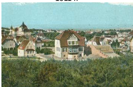
Willa Rentiera Dansera oraz obecna ul. Mickiewicza widziana z Cesarskiego Wzgórza, zdjęcie z 1911 r. (KC)
