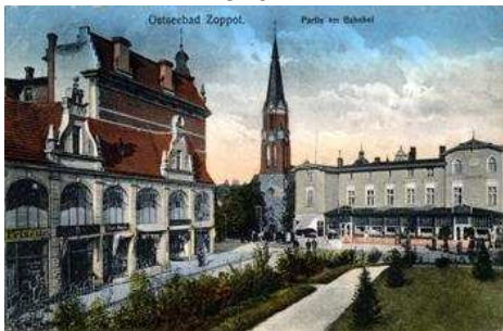
Skrzyżowanie ul. Dworcowej i ul. Podjazd, w tle widoczny Hotel Dworcowy oraz Dom Towarowy Fastów, zdjęcie z ok. 1910 r. źródło: Pan Daniel Szmytkowski - Projekt Dawny Sopot (DS)
