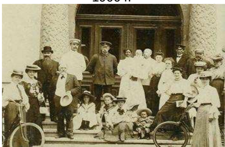
Wejście do Zakładu Balneologicznego od strony zachodniej, zdjęcie z ok. 1906 r. źródło: Pan Marcin Modzelewski (MM)
