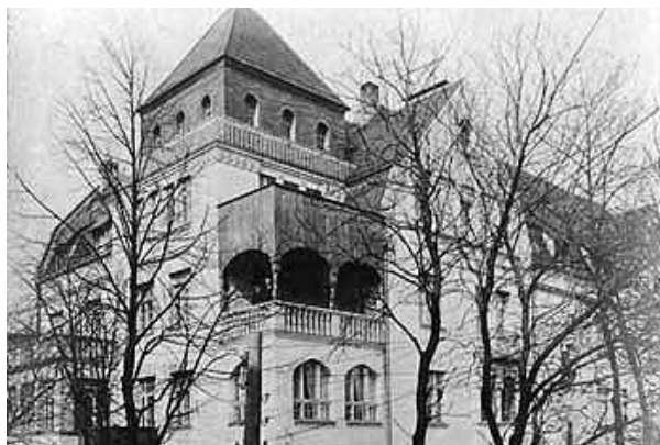
Kamienica Doktora Wegnera na skrzyżowaniu ul. Bomaterów Monte Cassino i ul. Haffnera, pierwotnie ul. Morska 33, zdjęcie z kwietnia 1909 r. (GK)
