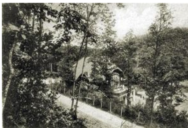
Widok na obecną ul. Moniuszki, widoczna strzelnica miejska, zdjęcie z ok. 1912 r. (TPS)
