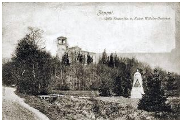
Willa i restauracja Stolzenfels widziana od strony obecnej ul. Haffnera i Parku Północnego, zdjęcie z ok. 1900 r. (TPS)
