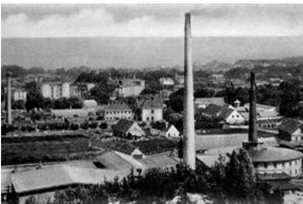
Komin i hala główna cegielni widoczna ze Strzeleckiego Wzgórza, zdjęcie z ok. 1900 r. (TPS)
