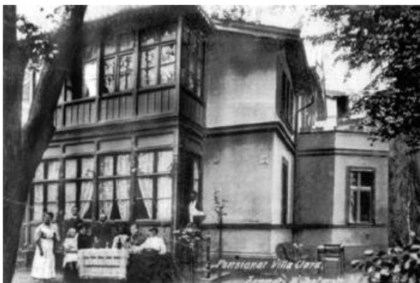
Pensjonat i Willa Clara przy dawnej ul. Wilhelma (ul. Łąkowej a obecnie ul. Haffnera), znajdująca się niegdyś pod numerem 20, zdjęcie z 1903 r. (TPS)
