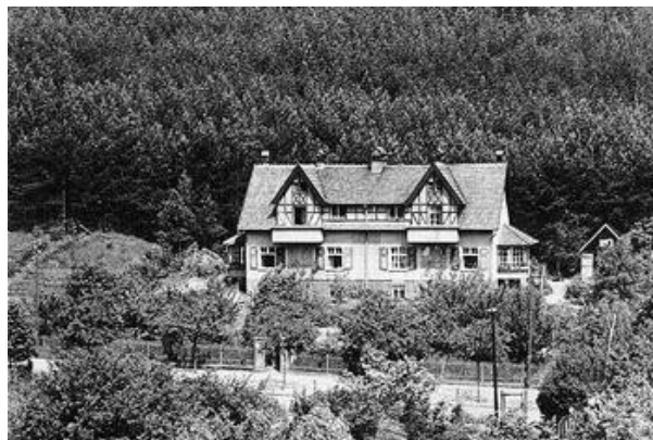
Willa wdowy po rektorze Klucke znajdująca się przy obecnej ul. Żeromskiego 8/10, zdjęcie z ok. 1920 r. (FDG)
