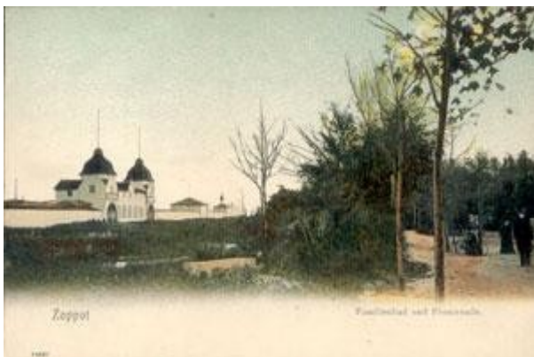
Łazienki Północne widziane od strony alejek Parku Północnego, zdjęcie z ok. 1904 r.
