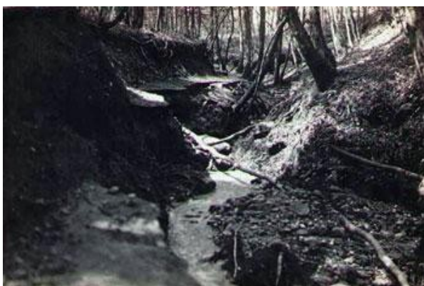
Południowa część drogi w jarze Swelinii zniszczona po ulewie w 1929 r., zdjęcie 1929 r. (GK)
