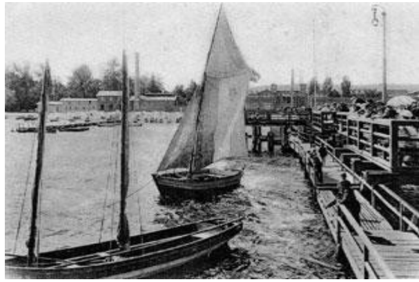
Komin zakładu balneologicznego zabudowany później latarnią, zdjęcie 1890 r. (TPS)
