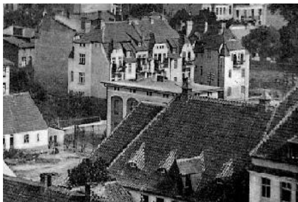
Budynek palmiarni na zdjęciu panoramy Sopotu wraz z Ujeżdżalnią Koni, zdjęcie z ok. 1920 r. (TPS)
