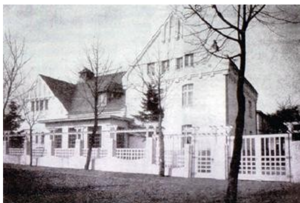
Dom dla urzędników i stajnie na terenie posiadłości Edwarda Herbst, zdjęcie z 1907 r. (MS Muzeum Sopotu, Biblioteka Główna PG, Ost. Bau-Zeitung)
