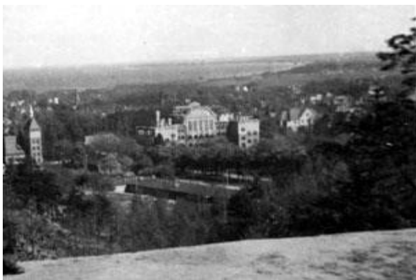
Widok ze wzgórza Strzeleckiego na ul. Strzelecką i zabudowania cegielni. W tle widoczny budynek Gimnazjum Realnego zburzonego częściowo w 1945 r. Niskie zabudowania widoczne na 2 planie to obóz pracy dla jeńców wojennych, zdjęcie z ok. 1947 r. (TPS)
