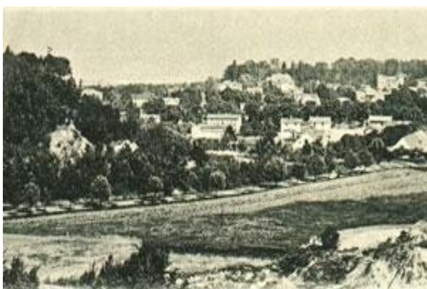
Obecna ul. 23 Marca biegnąca w Dolinie Gołębiewskiej, widoczne Królewskie Wzgórze (Stiewego), oraz obecna ul. Armii Krajowej, zdjęcie z 1898 r. (TPS)
