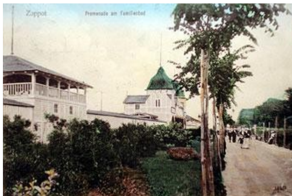
Łazienki Północne widziane od strony alejek Parku Północnego, zdjęcie z ok. 1907 r.
