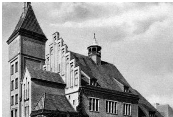
Remiza strażacka przy ul. Armii Krajowej (dawniej ul. Królewska), zdjęcie ok. 1900 r. (MM)
