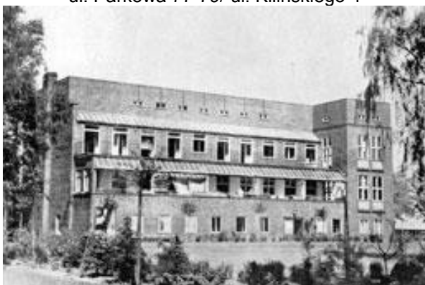
Przebudowany gmach Sanatorium Dziecięcego, zdjęcie z ok. 1930 r. (TPS)
