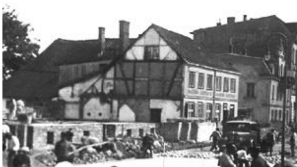
Rozbiórka wozowni Karczmy Sopockiej i kładzenie bruku na obecnej Al. Niepodległości, zdjęcie z 1901 r. (TPS)
