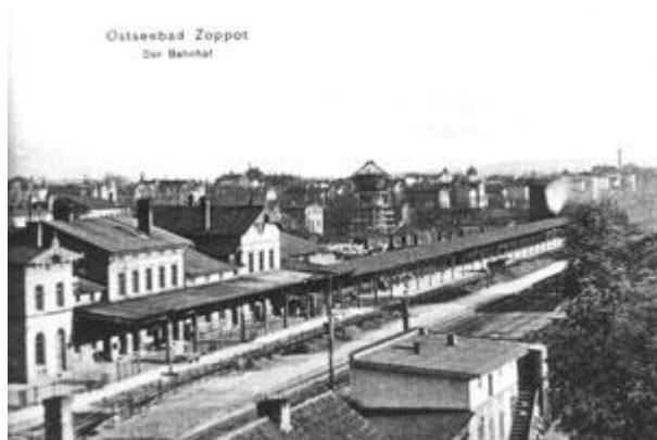
Stacja Kolejowa Sopot Główny w latach 30 XX w.
