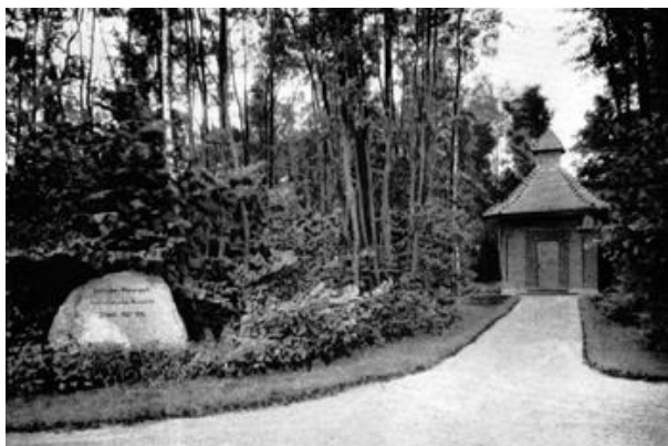
Ujęcie wody oraz głaz narzutowy upamiętniający jego otwarcie w 1926 r. u zakończenia obecnej ul. Kolberga, zdjęcie z ok. 1920 r. (TPS)
