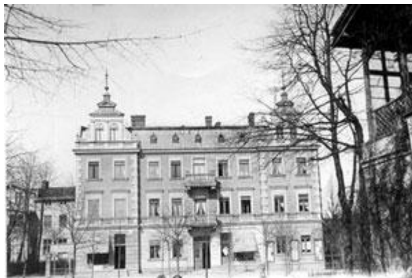
Kamienica Księgarni Muzycznej Constantina Ziemssena, po prawej stronie widoczny urząd gminy na obecnym Placu 3 Maja, zdjęcie ok. 1895 r. (FDG, GK)
