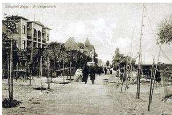
Alejką przy plaży w okolicy łaźniek południowych, widok na promenadę w kierunku mola, zdjęcie ok. 1900 r. (TPS)
