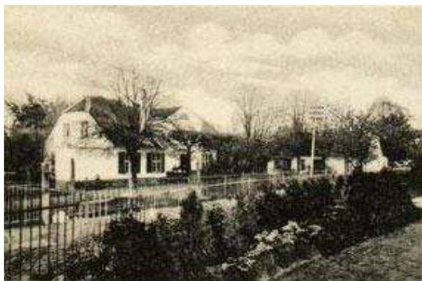
ul. Wpowstańców Westerplatte, domy nr 8 i 9, zdjęcie z ok. 1900 r. (TPS)
