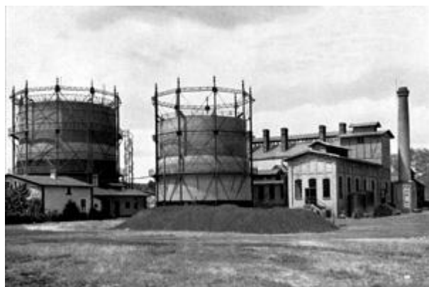
Gazownia Miejska ul. Bitwy pod Płowcami 23,25,27,31,31a
