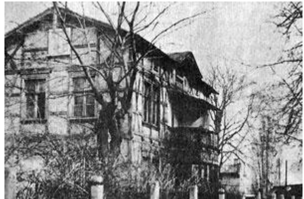
Odbudowany Hotel Victoria, zdjęcie druga połowa XX przed rozbiórką w 1971 r. (F. Mamuszka)
