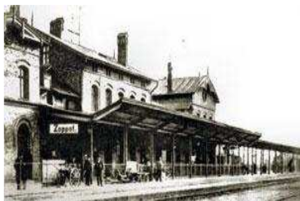
Dworzec Kolejowy ul. Dworcowa 7-9
