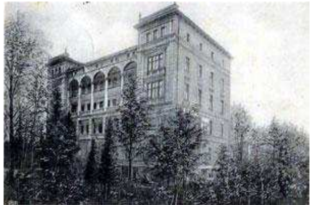
ul. Sobieskiego 35 - dawne Sanatorium Bałtyckie wzniesione w 1894 r. w neorenesansowym stylu, obecnie dom mieszkalny. Zdjęcie z 1916 r. (TPS)
