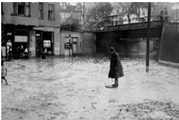
Ulica podjazd w czasie powodzi, zdjęcie z ok. 1930 r. (BG PAN)
