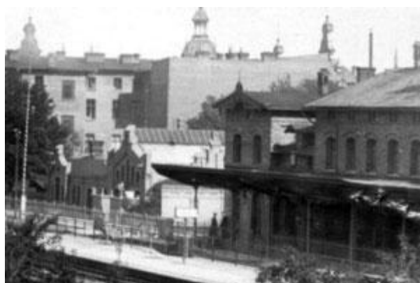
Dworzec Kolejowy ul. Dworcowa 7-9
