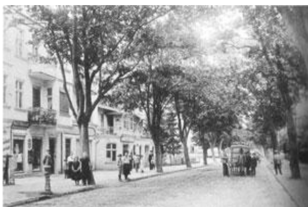
Al. Niepodległości, widok w kierunku gdańska, zdjęcie ok. 1905 r. (BG PAN)
