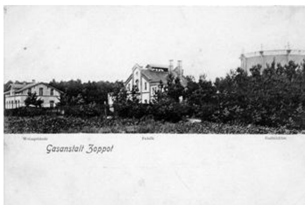
Gazownia Miejska ul. Bitwy pod Płowcami 23,25,27,31,31a
