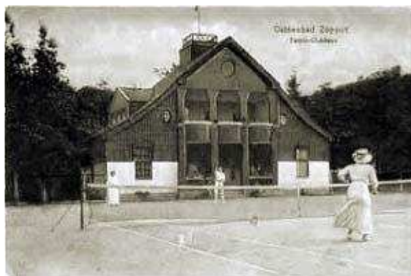
Budynek klubu tenisowego i korty tenisowe przy obecnej ul. Ceynowy, zdjęcie z ok. 1910 r. (TPS)
