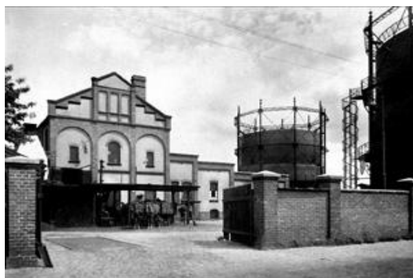
Gazownia Miejska ul. Bitwy pod Płowcami 23,25,27,31,31a
