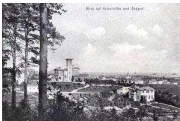
Widok na Cesarskie wzgórze, Restauracja i Hotel Powiertzne Sanatorium. W dole widoczna obecna ul. Reymonta i ul. Kasprowicza, zdjęcie ok. 1908 r. (TPS)
