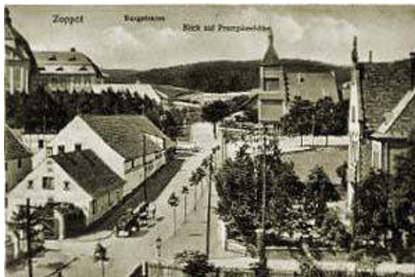
ul. 1 Maja po lewej w głębi budynek Uniwersytetu Gdańskiego (dawniej Gimnazjum Realne), remiza strażacka oraz po prawej stronie budynek sądu rejonowego, zdjęcie ok. 1910 r.
