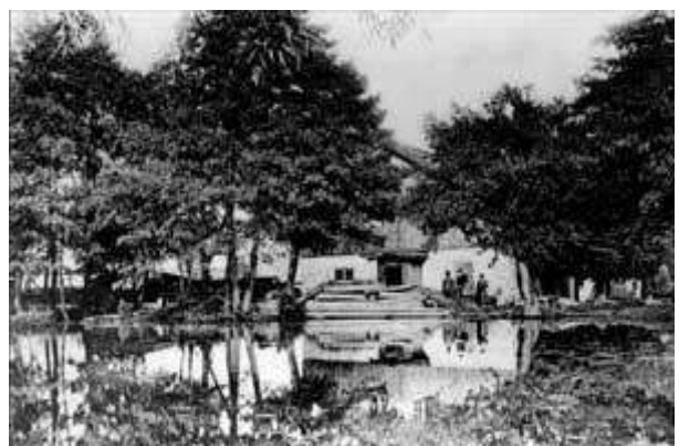
Młyn na Kamiennym Potoku z widocznym stawem młyńskim, zdjęcie 1904 r. (TPS BG PAN)
