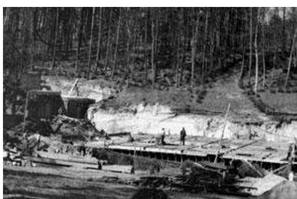
Przebudowa sceny Opery Leśnej w Sopocie, zdjęcie 1966 r. (TPS)
