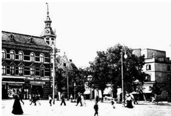
Pierwotny wygląd budynku, na miejscu którego powstała Kamienica Mendelsohna, zdjęcie z ok. 1905 r. (TPS)
