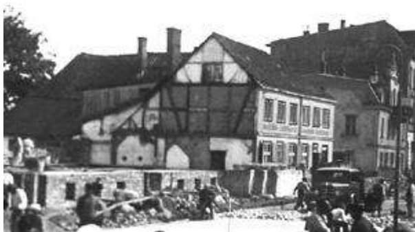
Rozbiórka wozowni Karczmy Sopockiej i kładzenie bruku na obecnej Al. Niepodległości, zdjęcie 1901 r. (TPS)
