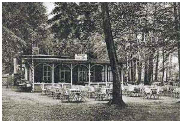
Restauracja Wielka Gwiazda znajdująca się na skrzyżowaniu dróg leśnych - przedłużeniu ul. 23 Marca (obecnie nie istnieje, widoczny jest jeszcze nasyp tramwaju konnego oraz fundamenty restauracji), zdjęcie 1898 r. (TPS)
