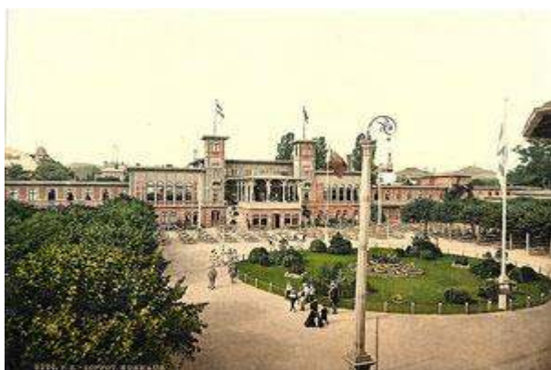
Dawny budynek Domu Zdrojowego w Sopocie z 1900 r. Drewniana konstrukcja, przebudowana w 1910 r. (US Library of Congress)
