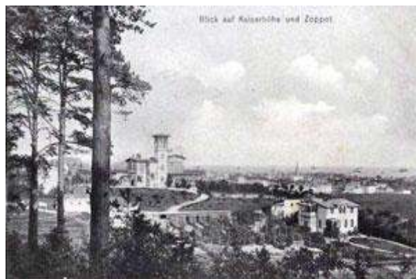
Widok na Cesarskie wzgórze, Restauracja i Hotel Powietrzne Sanatorium. W dole widoczna obecna ul. Reymonta i ul. Kasprowiczka, zdjęcie ok. 1908 r. (TPS)
