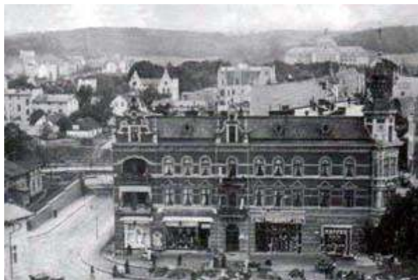
Nie istniejący w całości budynek przy placu Konstytucji 3 Maja i ul. Podjazd, ze sklepami na parterze i mieszkaniami na wyższych kondygnacjach, zdjęcie z ok. 1913 r. (TPS)
