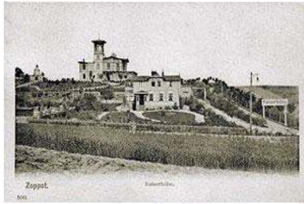
Widok na Cesarskie Wzgórze, Restauracja i sanatorium Kaiserhöhe z obecnej ul. Reymonta, zdjęcie z ok. 1906 r.
