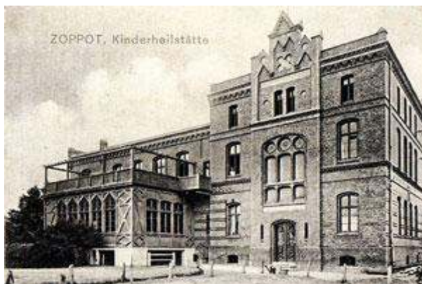
Sanatorium Dziecięce widziane od frontu, zdjęcie ok. 1915 r. (TPS)
