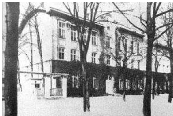
Budynek Szkoły Gminnej przy dawnej ul. Szkolnej, zdjęcie ok 1920 r. (Sopot Kronika XX w.)
