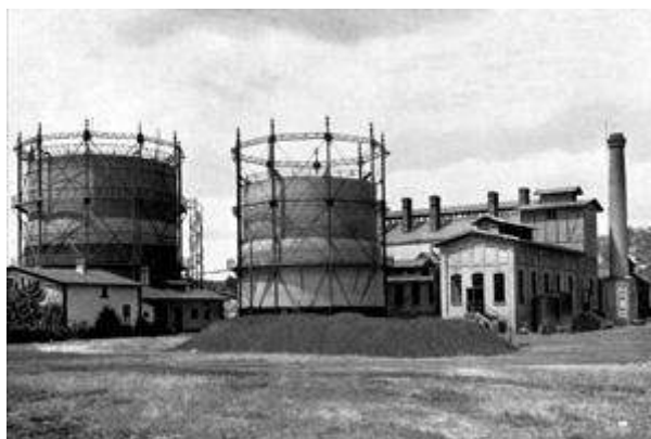
Zbiorniki gazowni rozebrane w latach dziewięćdziesiątych XX w., zdjęcie 1928 r. (TPS)
