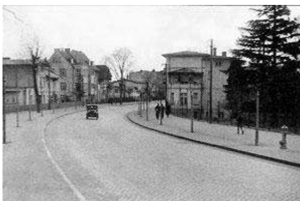
Al. Niepodległości, skrzyżowanie z obecną ul. Goyki, zdjęcie ok. 1931 r. (Sopot Kronika XX w.)
