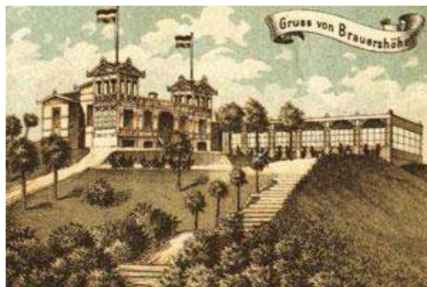
Widok na wzgórze piwowarskie i restaurację, z charakterystycznymi schodkami prowadzącymi z alejek nadmorskich na wzgórze, zdjęcie koniec XIX w. (TPS)
