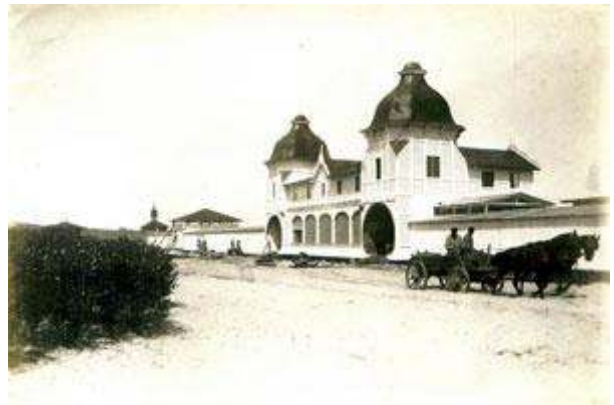
Łazienki Północne w budowie, zdjęcie autorstwa Johna Faltina, 1903 r. (DS)
